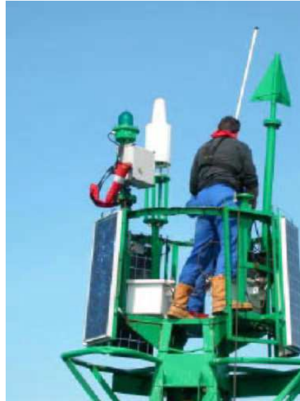
Figure 1 : Installation du Racon sur une bouée. / Installation of the Racon on a buoy.
